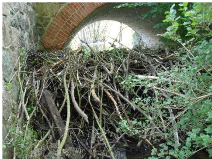
Bahndamm im Radebach (Blankenberg)
